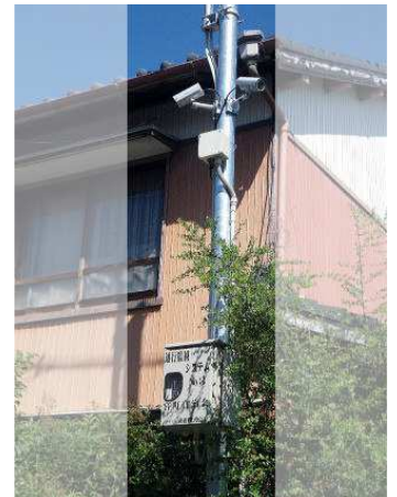
子局(VL/SU)及びカメラ・システム機器ボックス
