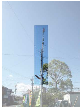
子局(VL/SU)及びカメラ・システム機器ボックス(遮光板付)
