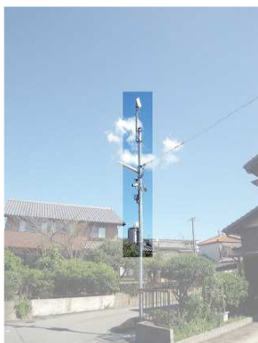
子局(VL/SU)及びカメラ・システム機器ボックス
