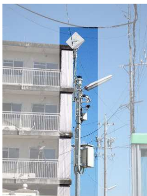
VL/SU 本体及び空中線設置用継柱ポール
